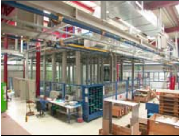
Abb. 2) Badanlage mit Umsetzersystem
